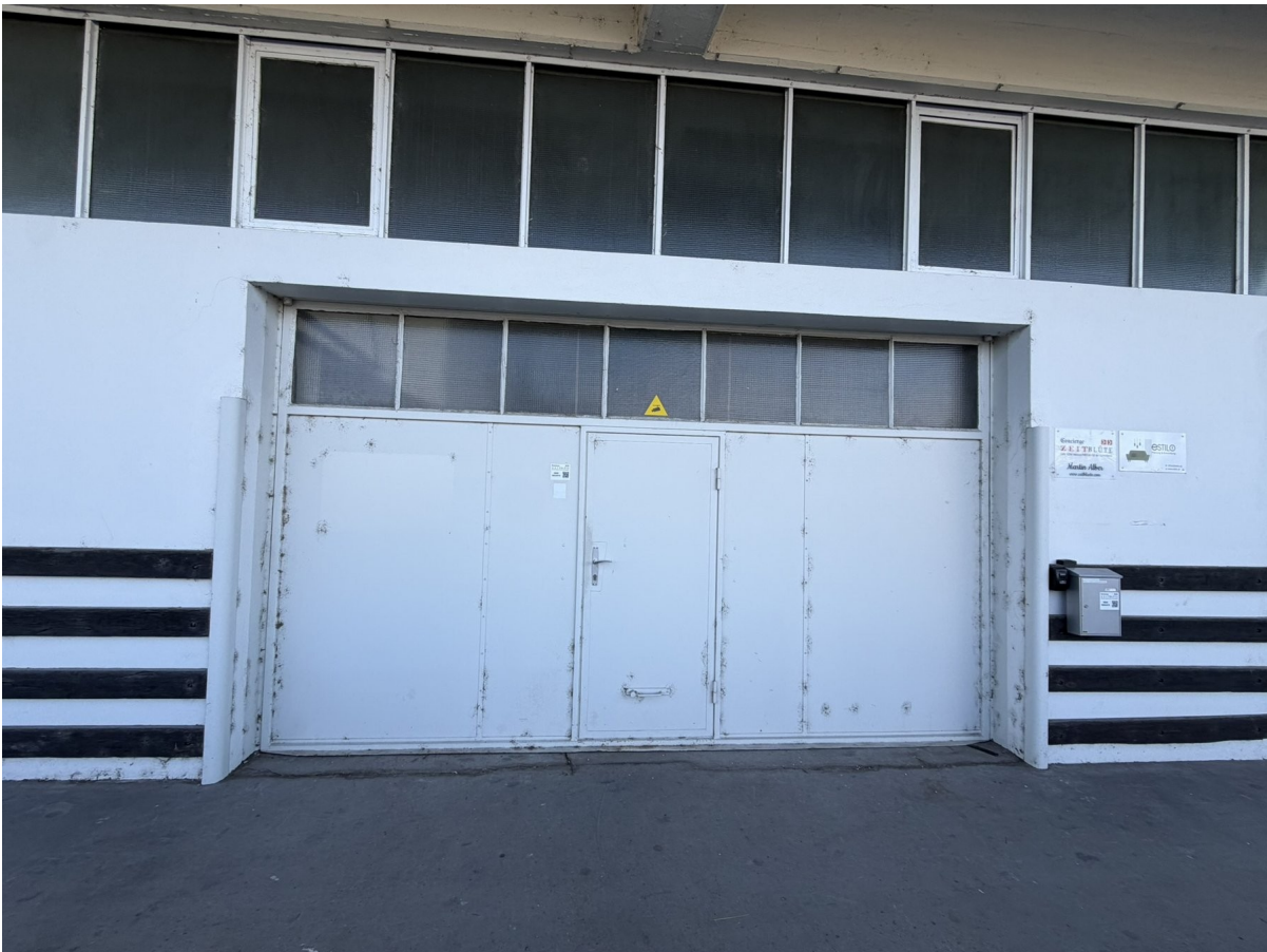
Zugang L6 an der überdachten Laderampe
