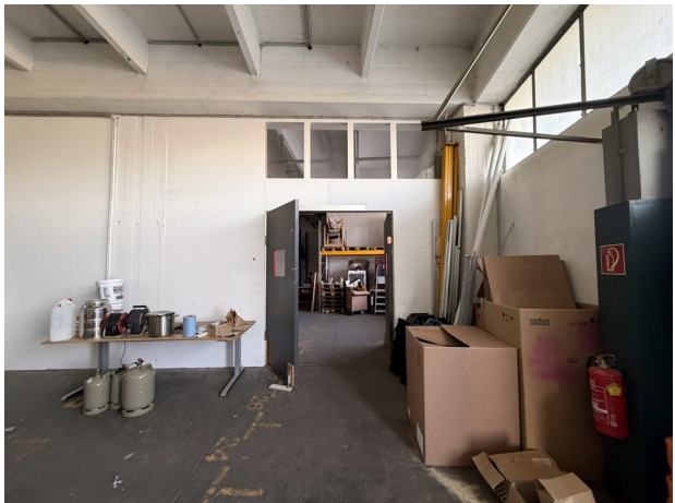
Fensterband und Verbindungstür
