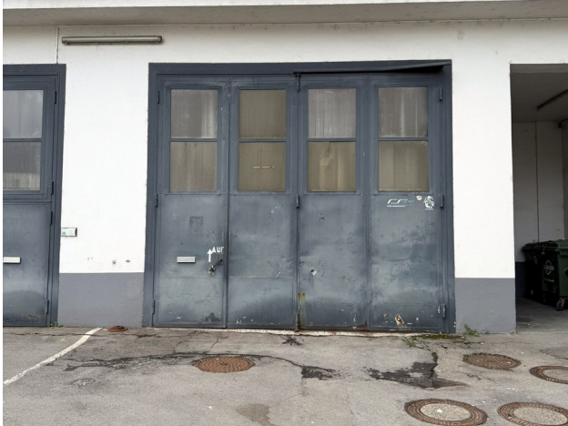
Einfahrt vom Hof: Stahl-Falttor ca. 4 m breit
