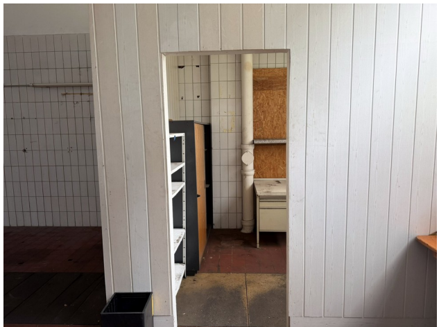
Nebenraum hinter der Trennwand
